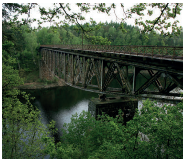
Stalowy kratownicowy most w Pilchowicach fot. Depositphotos.com
